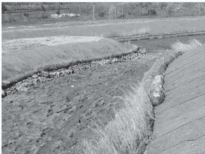
Figura 20.2. Restauración de suelos. Preparación del sustrato para la instalación de vegetación ribereña ( Scirpus , Typha , etc.) en una laguna restaurada.
